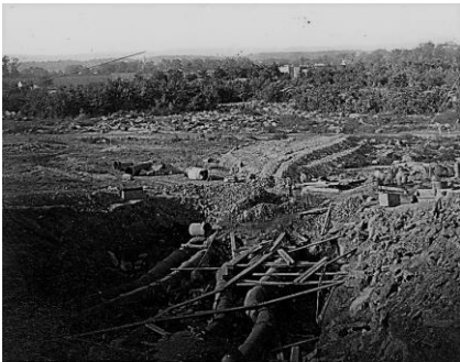
Construcción de Central Park, 1962. WordPress.com
